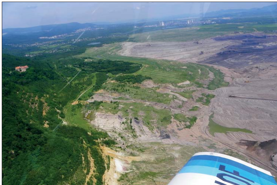
Obr. 1 – Stabilizační pilíř při úpatí tektonicky porušeného krušnohorského svahu pod zámek Jezeří. Charakteristický je sesuvný typ reliéfu v oblasti jihozápadně orientovaných svahů, v pozadí dolové pole lomu ČSA. Foto: J. Burda 2010.
