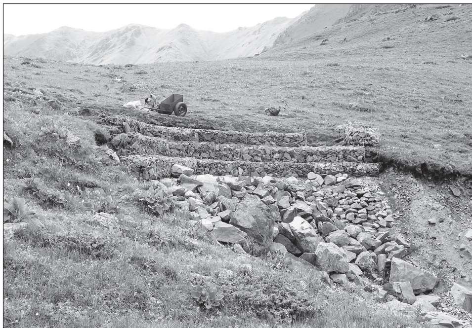
Obr. 1 – Ukázka praktického výsledku projektu: podle našeho návrhu byla stabilizována horní část erozní rýhy na vzdušné straně hráze sesuvem hrazeného jezera Koltor (Kyrgyzský hřbet, Tan-Šan) pomocí drátěných sítí a kamenné rovnániny. Při zvýšeném přítoku vody do jezera (vlivem intenzivního tání ledovců či srážek) dochází k přelivu hráze a následně erozi, která způsobuje postupné zeslabování hráze. Foto: M. Šobr
